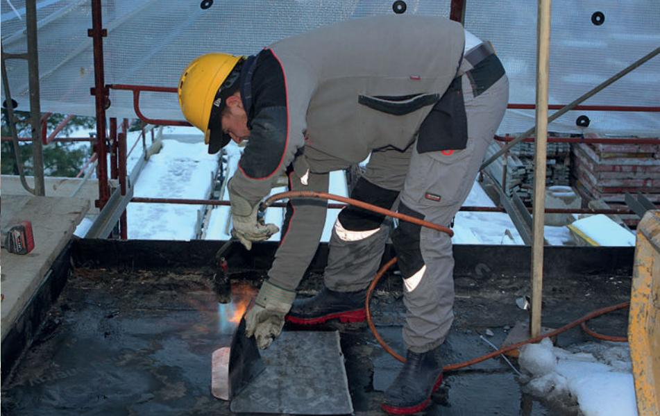
Les bandes de bitume sont soudées au moyen d'un chalumeau.
