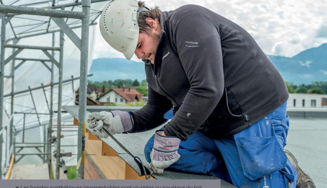
▲ Les bandes synthétiques imperméables sont ajustées au pourtour du toit.
