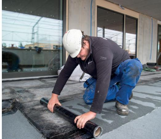
**▲ Déploiement des bandes de bitume** Les bandes bitumineuses sont d'abord déroulées. Le dessous est ensuite chauffé avec un chalumeau pour qu'elles puissent se lier à la sous-couche.
