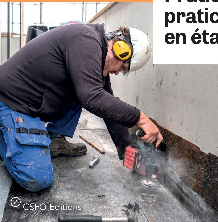
Qui dit toit plat étanche et bien isolé dit bâtiment protégé, mais aussi énergie économisée. Pour cela, les étancheurs et les praticiens en étanchéité mettent en place l'isolant thermique, puis posent et soudent des bandes bitumineuses ou synthétiques. Végétaliser une toiture, installer des panneaux solaires, rendre étanches des ponts et des tunnels: toutes ces tâches font aussi partie du métier.
